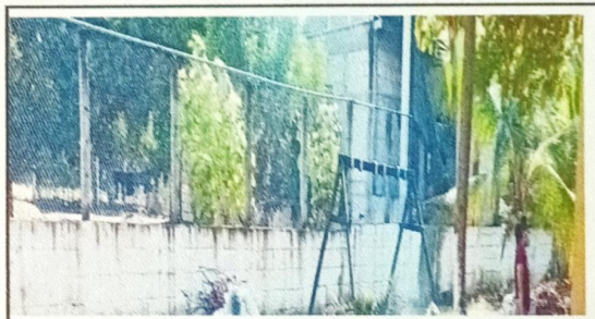
Foto 4: Reparación de muro perimetral de block
