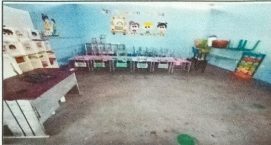
Foto 1: Sustitución de piso de concreto por piso cerámico
