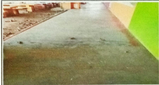
Foto 2: Sustitución de piso de concreto por piso cerámico
