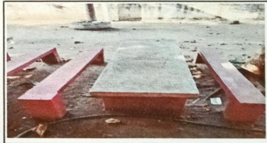
Foto 6: Instalación de azulejos en mesas de concreto
