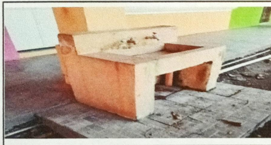
Foto 5: Instalación de azulejos en piletas de concreto
